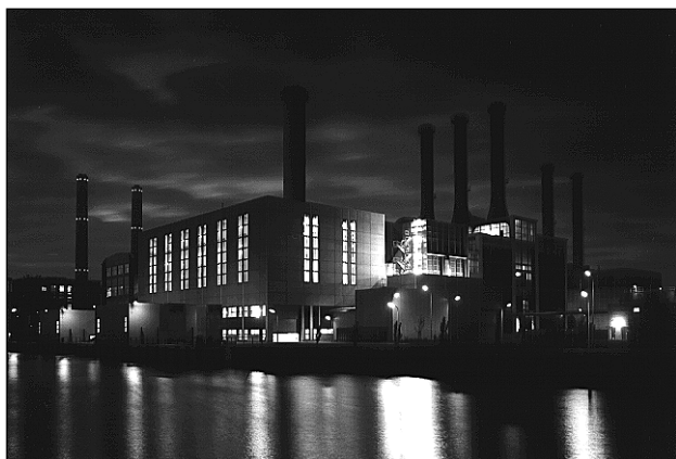
Figura 19: centrale termoelettrica e di riscaldamento di «Merwedekanaal» presso Utrecht nei Paesi Bassi, con una potenza elettrica di 225 MW.
