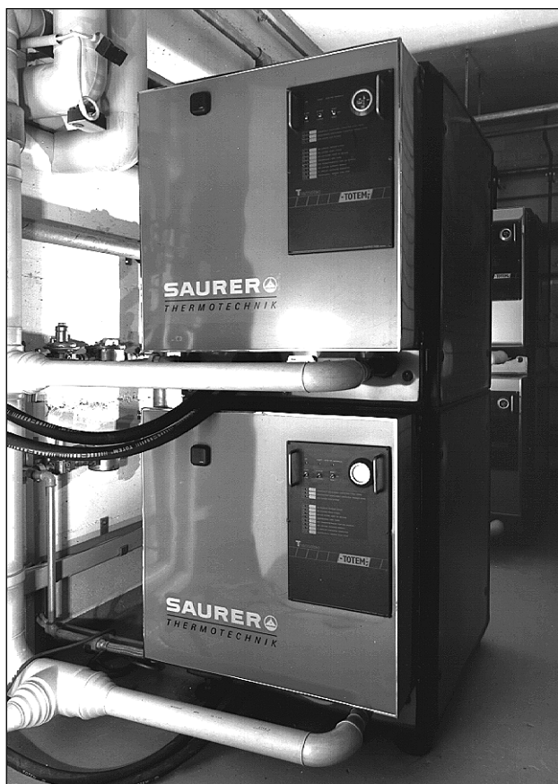
Figura 22: quattro piccole centrali termoelettriche e di riscaldamento compatte con una potenza elettrica di 4 x 15 kW forniscono insieme una potenza di riscaldamento di 156 kW.
